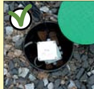
Netzteil in Elektrogehäuse, erhöht eingelegt, Drainage für Bodenschacht vorsehen
