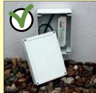
Korrekte Installation im Elektogehäuse
